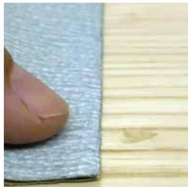
**3** 硬化後、研磨して平滑面として完了です。
