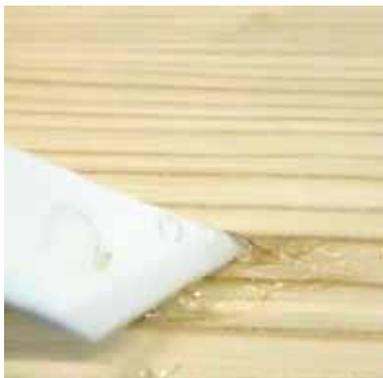
**1** パテ埋めをする箇所及びまわりのゴミ、汚れを取り除き、傷、穴にパテ液をヘラ等で充填します。
